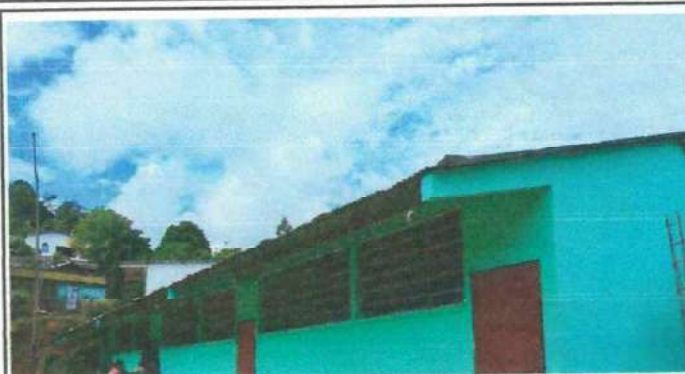
Foto 2: Se observa la estructura portante.
