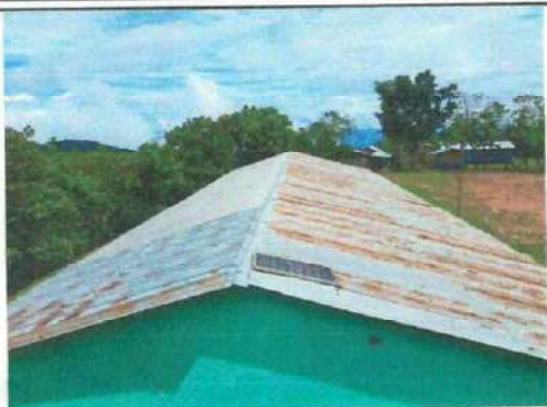
Foto 1: Se observa el deterioro de las láminas portantes del modulo 1.
