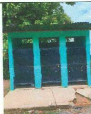
Foto 6: Cambio de tres puertas del baño y cambio de inodoros.
