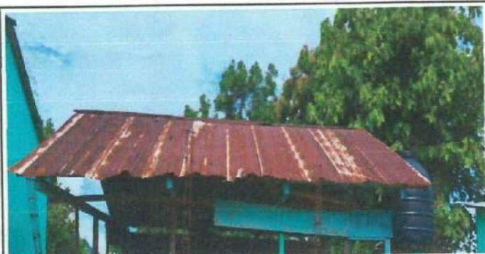
Foto 5: Se observa el deterioro de las láminas portante de la cocina.
