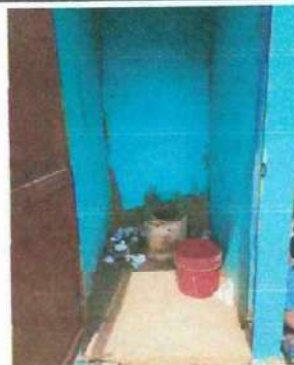
Foto 4: Se observa el baño portante.
